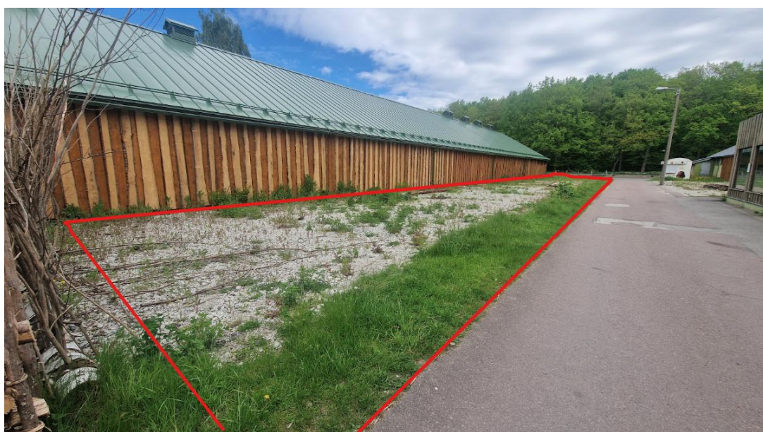
Foto 2. Vaade edelast. Töömaa külgnab antilobimaja taguse ja asfalteeritud jalutusteega. Madalseikluspargi teepoolsel küljel tuleks välistada multši vms hakkepuidu valgumist jalutusteele (sobiv servalahendus: madal palk, mururiba vms).
