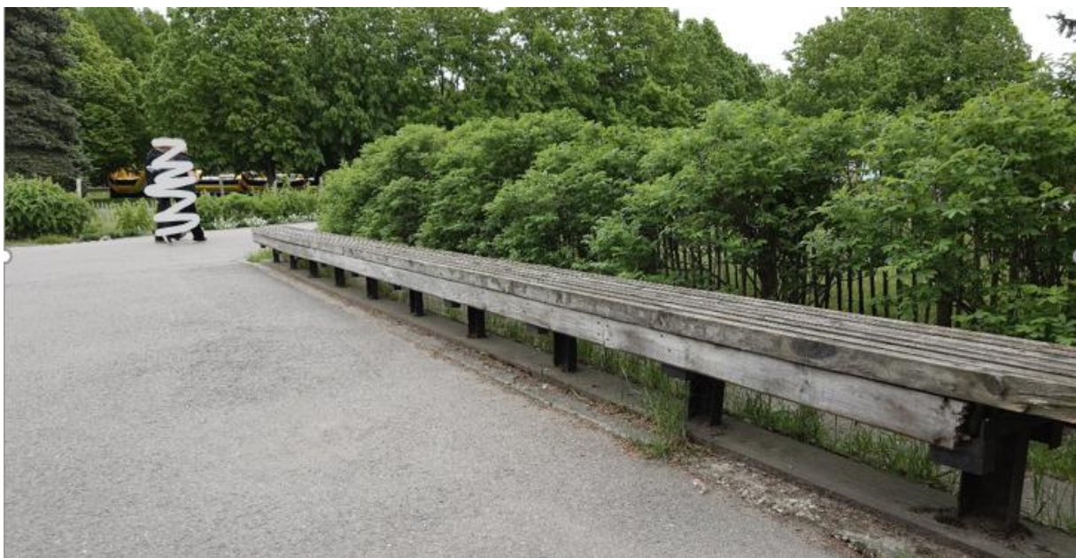
Fotod 5, 6, 7. Teisaldatavad ja utiliseeritavad teraskonstruktsioonil pingid on kinnitatud betoonalusele.
